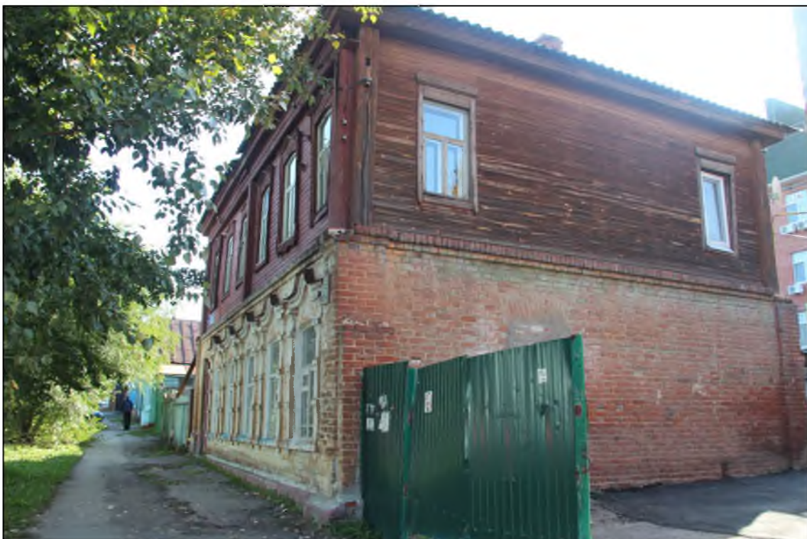
г. Ульяновск, ул. Андрея Блаженного, 36. Вид с улицы Андрея Блаженного на главный северо-западный фасад и боковой юго-западный фасад. Современное фото.
