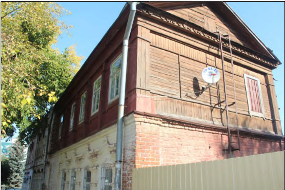
г. Ульяновск, ул. Андрея Блаженного, 34. Вид с улицы Александра Матросова на юго-западный фасад и боковой юго-восточный фасад полукаменного двухэтажного флигеля. Современное фото.
